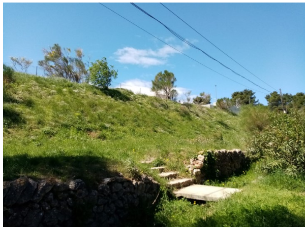
Foto 3 i 4: Talús de de l'ETAP
